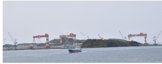
三菱の香焼工場の艀装岸壁には、船の姿はなく、ひっそりしていました。ドックは大島造船への売却が予定されています。
