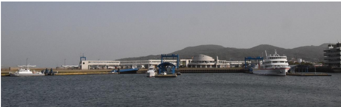
福江港のフェリー岸壁の全景です。手前の 2 本が小型客船用の浮桟橋で、九州商船と野母商船の大型客船は、ターミナルの裏側の岸壁に着きます。
